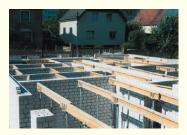
Erdberührte Außenwandflächen und der Überstand der Kellersohlplatte erhalten eine maschinell aufgebrachte Dickbeschichtung Fabr. SCHOMBURG gegen nichtstauendes Sickerwasser. Zusätzlich erhält der Fußpunkt im Bereich des Überganges zwischen
